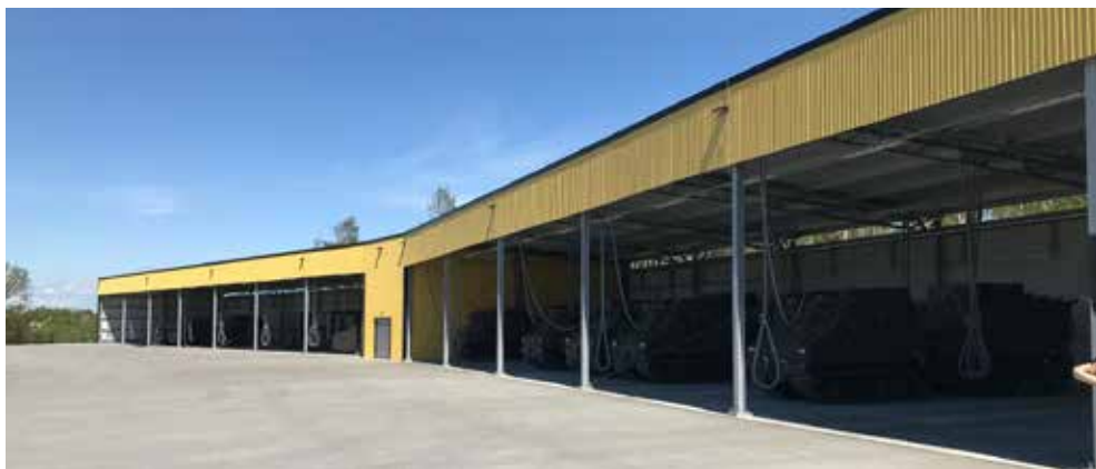
Stolpladan på Flaggstångshöjden är också ett objekt som har byggts för att husera nytillkommen materiel. Foto: Lv 6.
